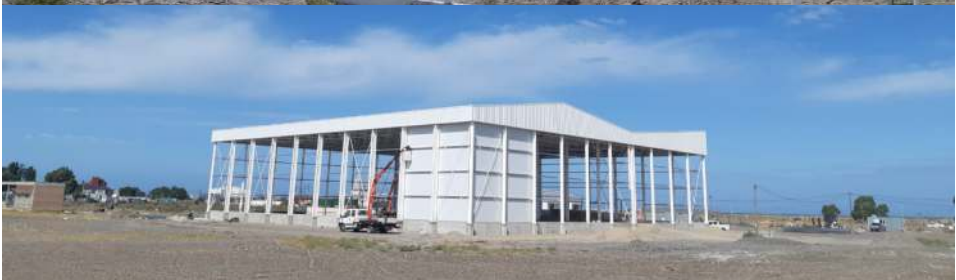
Obra Nueva Línea de Producción Langostino IQF - Rawson
